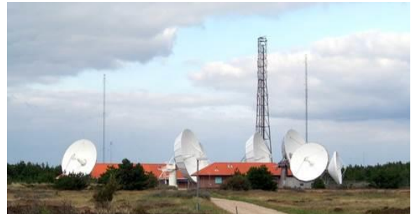
Blåvand Radio og antenneanlæg, syd for lokalplanområdet.
